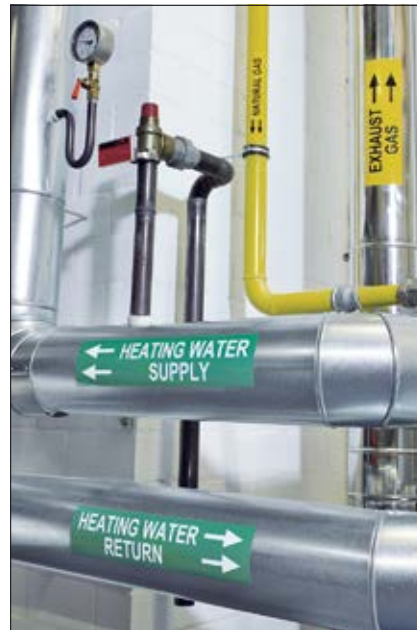
Stor og meget synlig merking av rør.
