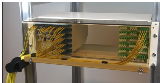
3U ramme med moduler, 0.5U kabelrenne og 3U deksel
