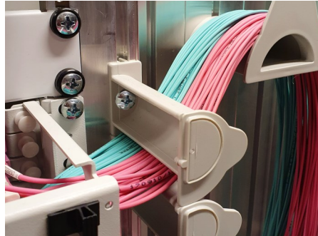
Bøybegrenser kan sikres ekstra med skruer/mutter
