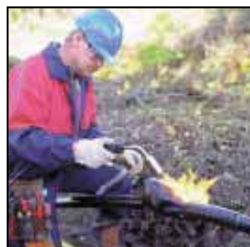
Kabelarbeid – Plastkrymping Side 13
